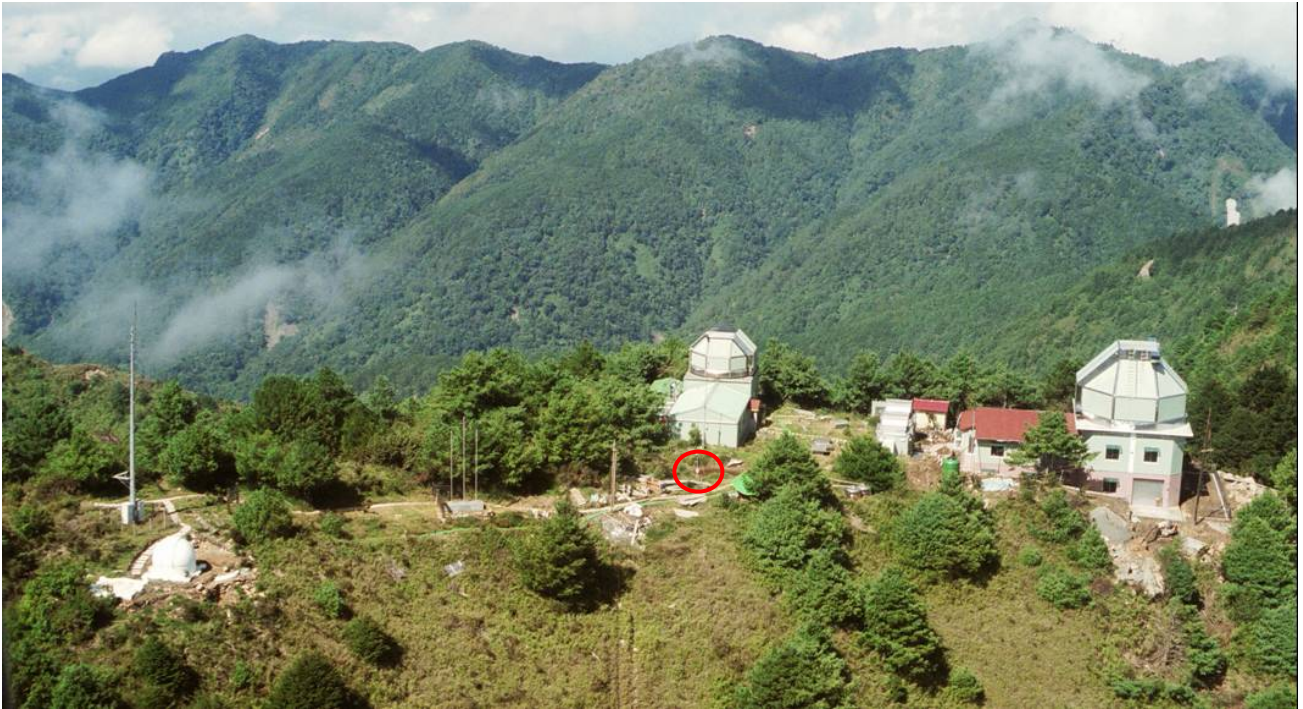
氣象站設置位置
