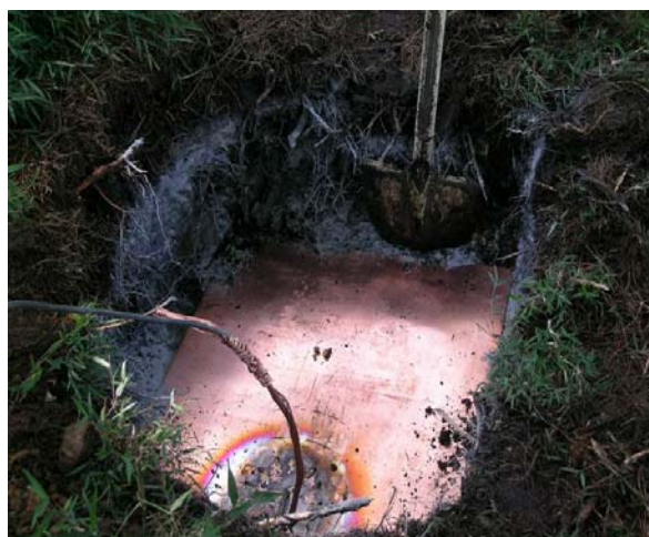
戶外增設之導電銅板
