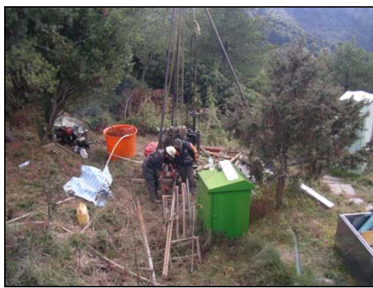
鑽探施工照片
