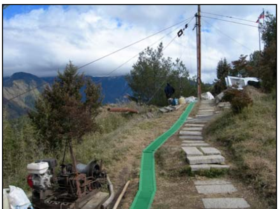
鋼索吊搬機具照片
