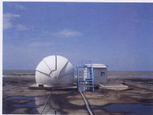
「中央大學遠距遙控天文台」位於屏東縣車城鄉「國立海洋生物博物館」內「水族實驗中心」的樓頂上。天文台使用一座雙向開闔的蚌殼式圓頂。
