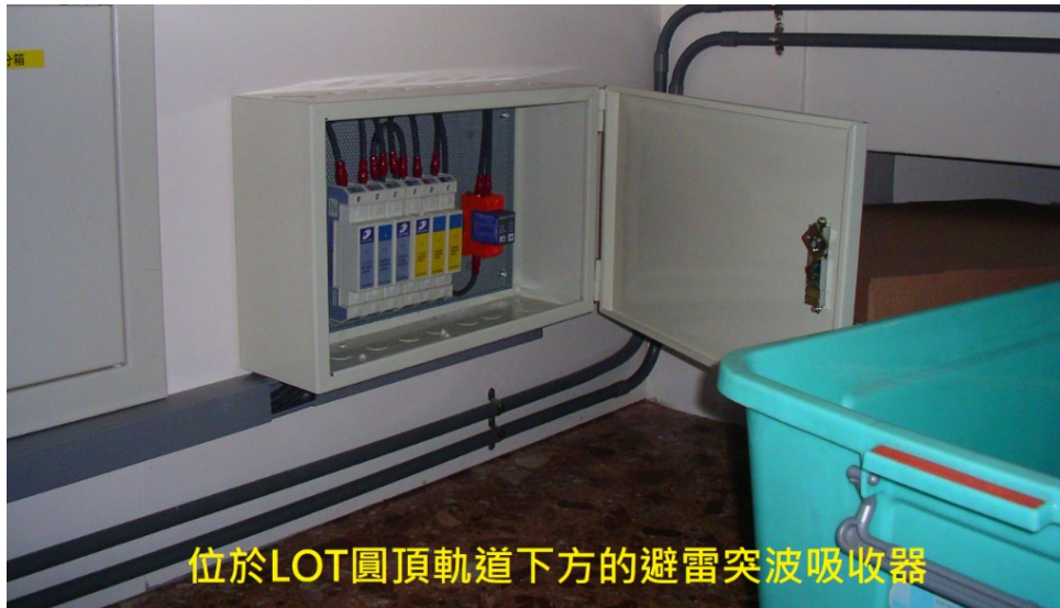
Figure 13: 2005 年 2 月增設之避雷突波吸收器
