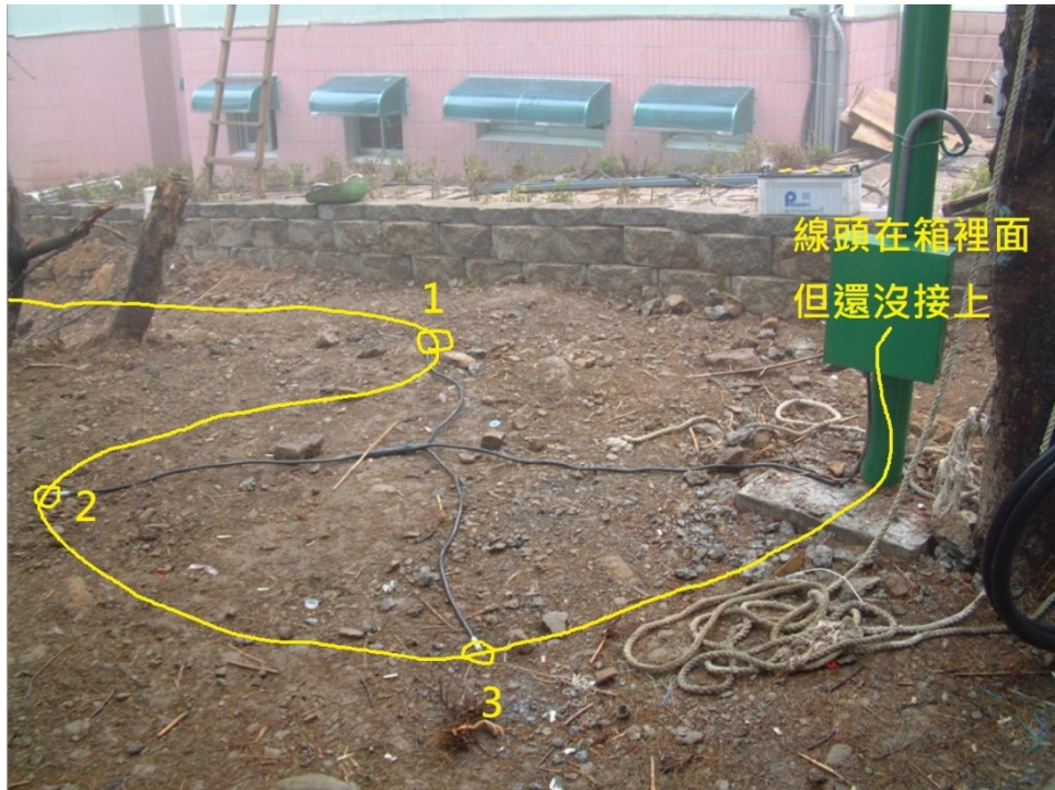
Figure 21: 與避雷針系統並線
