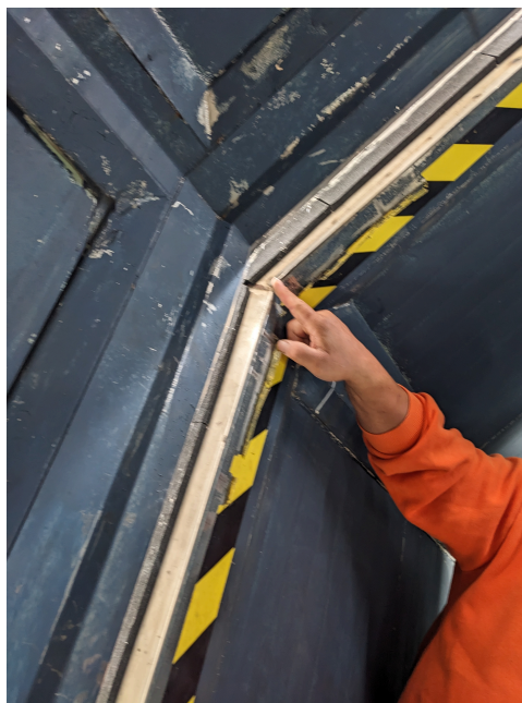
Figure 25: SLT 天窗卡住的位置
