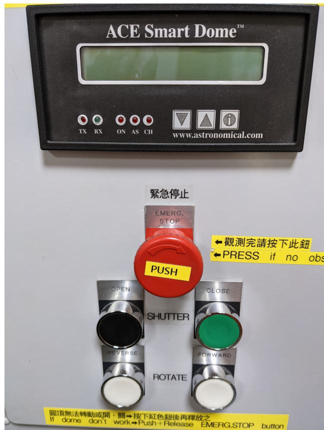
1. LOT 圓頂的旋轉一圈讀數 (Encoder Counts per 360°) 固定為 65,535，無法修改！正確值應約為 64,xxx (搭配 360 P/R Encoder 時)。因此，圓頂與望遠鏡的連動存在些許誤差。但由於 LOT 圓頂天窗開口比望遠鏡大兩倍，尚不至於遮蔽望遠鏡。
