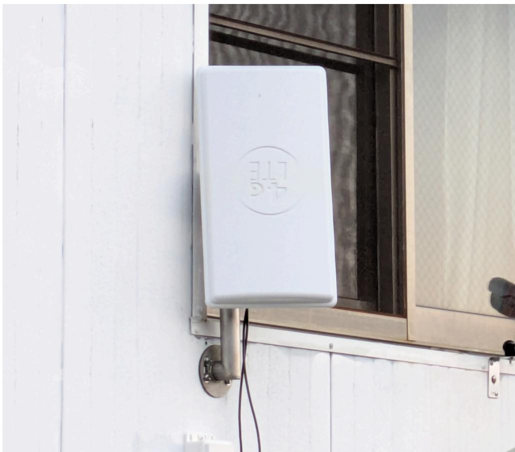
Figure 21: 新 4G 24DB LTE 室外平板定向天線
