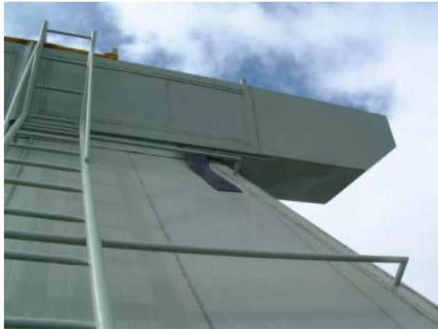
5. LOT 天窗剛開始時有被吹開現象，將天窗下方用 C 形夾及吊索固定。但天窗正上方還是被吹開一道縫，有雨水落進來，幸好 LOT 有穿雨水=>天亮後發現兩扇天窗上方皆脫軌，目前已經頂回原軌道，LOT 圓頂"門"脫軌，圓頂旋轉軌道並未脫軌。下午已經將脫軌之處推回，修復後圓頂看起來可以運作。(剛剛與陳老闆聯絡，證實在圓頂組裝時曾經發生過同樣情形，推回即可正常運作)。強風時整個 DOME 會劇烈震動，好像快被掀開。更令人擔心的是兩扇天窗則互相撞擊，好像快掉出去似的。雖然目前 LOT DOME 還在，但是是否經得住下次更大颱風？需要加強防颱機制以確保望遠鏡等儀器安全。
